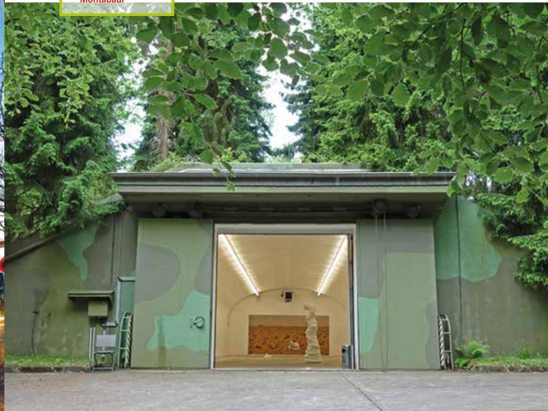
b-05 Galeriebunker Montabaur
